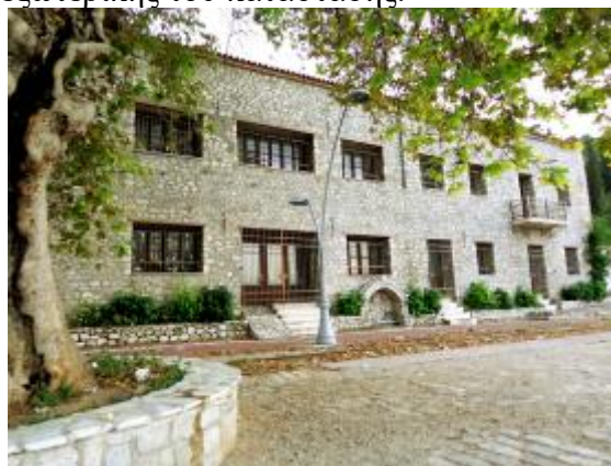
Εικόνα 1: Απεικόνιση της παραλιακής όψης του κτηρίου
