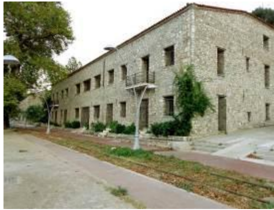
Εικόνα 2: Απεικόνιση βόρειας και τμήματος της δυτικής όψης του κτηρίου μελέτης
